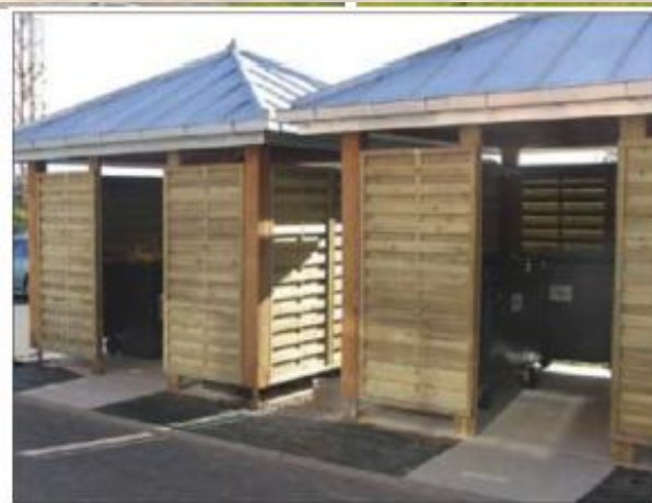
Un exemple d'intégration des bennes destinées à la collecte sélective.
